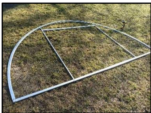
Obrázek 1 - Schéma montáže čel konstrukce – pohled z vnitřku skleníku
