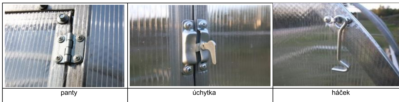
Obrázek 4 - způsob upevnění pantů, úchytky a háčku
