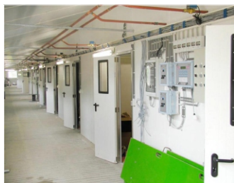
Chodba s vnitřními dveřmi a okny
